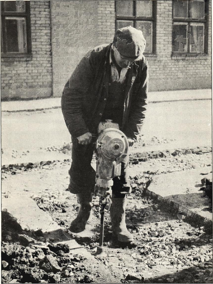
vom Bohren auf Aufbrechen nicht mehr des Auswechslens zweier Maschinenteile bedarf, sondern eine einfache Hebelschaltung genügt. Ein schwimmerloser Vergaser gestattet störungsfreies Arbeiten des Motors, auch wenn bis zu 45 Grad aufwärts gebohrt werden soll, was bisher nur bei der Vorführung erprobt wurde.
