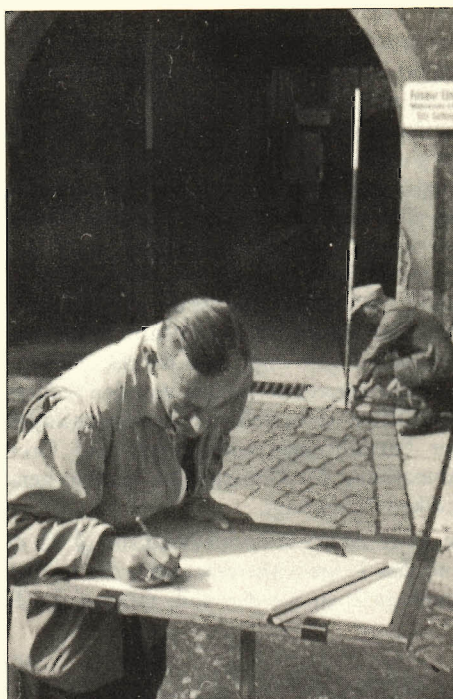
Die Feldmaße werden in den Vermessungsriß eingetragen
