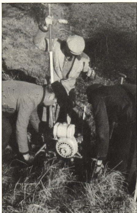
Zur Beschleunigung der Abmarkungsarbeiten wird ein Steinsetzgerät verwendet
