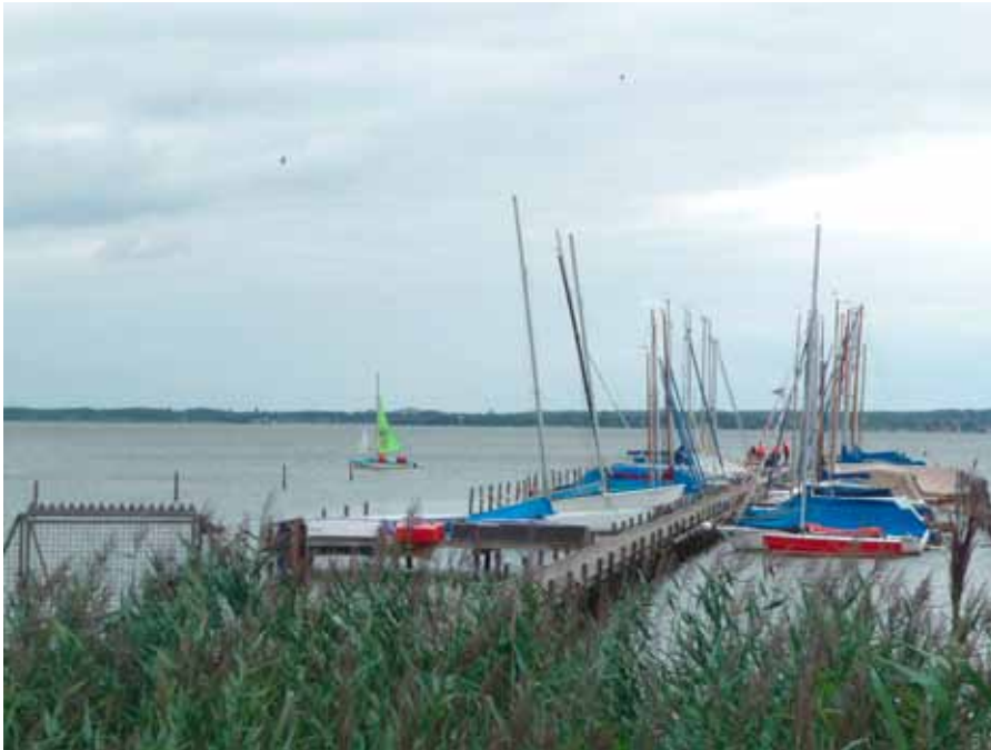
Abb. 1: Vor-Ort-Kontrolle der Steganlagen und Anwachsflächen
