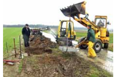
Abb. 16: Einbringen der Granitplatte
