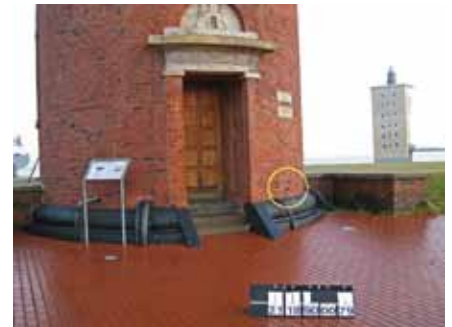
Abb. 10: Mauerbolzen am Leuchtturm „Alte Liebe“ in Cuxhaven
