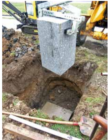
Abb. 17: Einbringen des Granitpfeilers
