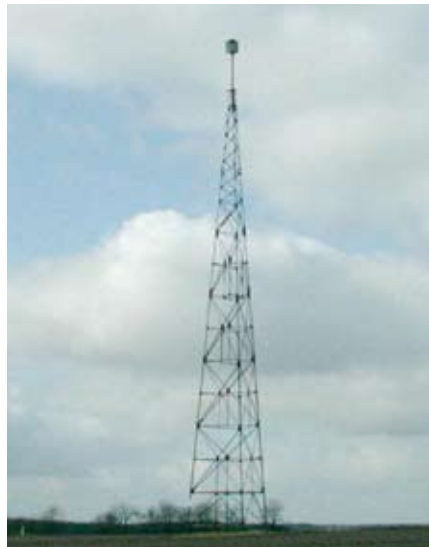
Abb. 14: Die als Stahlgitterkonstruktionen erneuerten Türme der Basis Ost bei Groß Stavern und Basis West bei Klein Stavern, wie sie sich heute präsentieren
