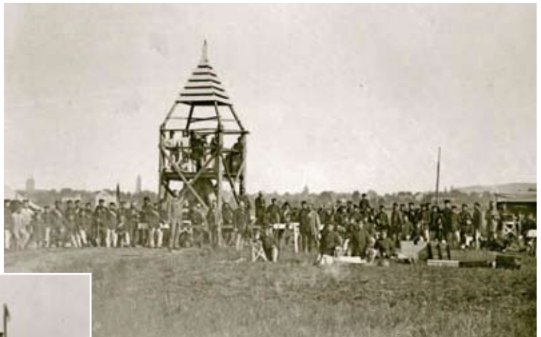
Abb. 12: Das Foto zeigt eine Endpunktpyramide der Göttinger Basis /11/. Dieses Gruppenfoto zeigt besonders deutlich den hohen personellen Aufwand: Mehr als 80 Menschen waren erforderlich.
