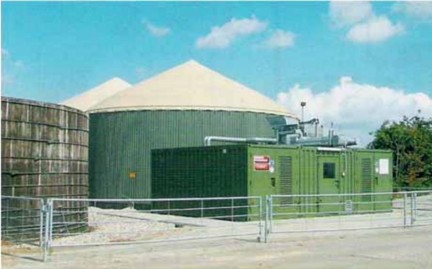
Abb. 4: Fermenter mit integriertem Gasspeicher, BHKW-Container und Gärückstandslager
