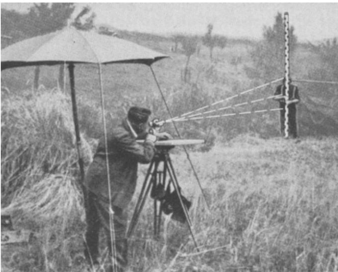
**Abb. 16:** Tachymetrische Geländeaufnahme mit Messtisch, Kippregel und Ziellatte, wie auch für die TK10 HBS durchgeführt, historisches Foto, abgeb. in Grothenn 1994.
