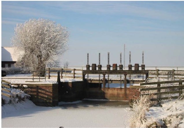
Beispiel Wehranlage Trumpföhre (Quelle: Foto, Inros Lackner)
