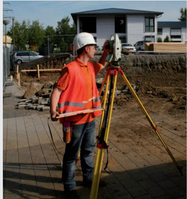
Anschließend erfolgt die Übertragung der Absteckpunkte in die Örtlichkeit (z. B. auf ein Schnurgerüst oder in die Baugrube).
