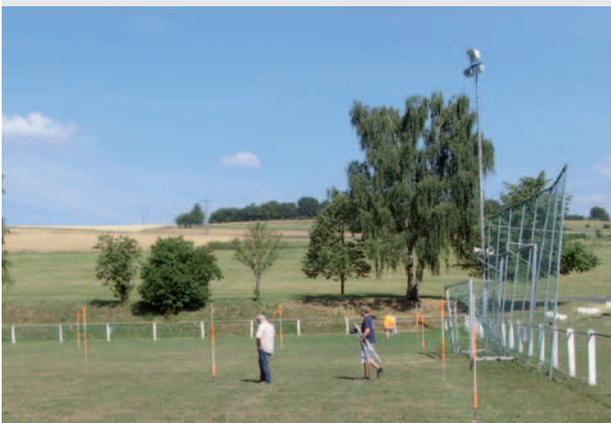
Diese Verfahrensweise wird so lange wiederholt, bis alle gewünschten Punkte abgesteckt sind. Nun werden die Kontrollen zwischen den Punkten mit dem Messband gemessen und damit die Absteckung überprüft. Sind alle Punkte überprüft und kontrolliert **und** richtig abgesteckt, können die Punkte abgemarkt und mit Sprühfarbe markiert werden.
